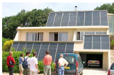
Visite installation solaire
