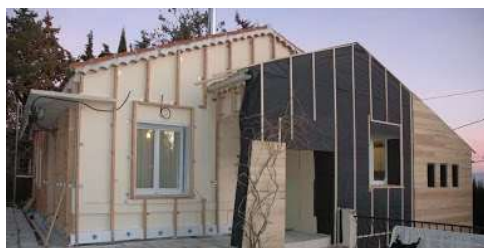
Visite de chantier isolation par l'extérieur
